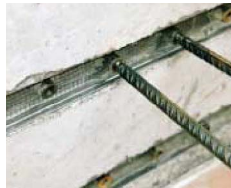
Elementi per le riprese di getto avvitabili
