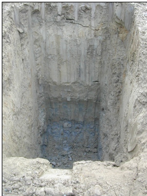
Pozzetto esplorativo eseguito da escavatore
