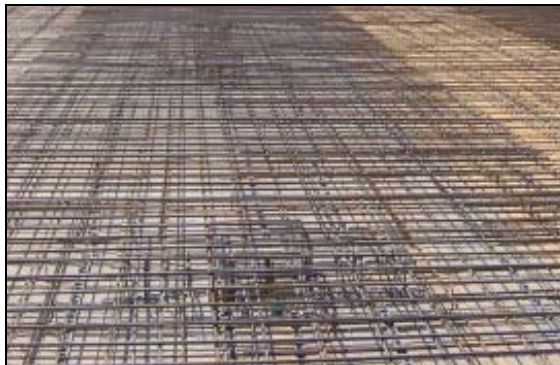
Esempio tipologico: piastra a soletta piena
