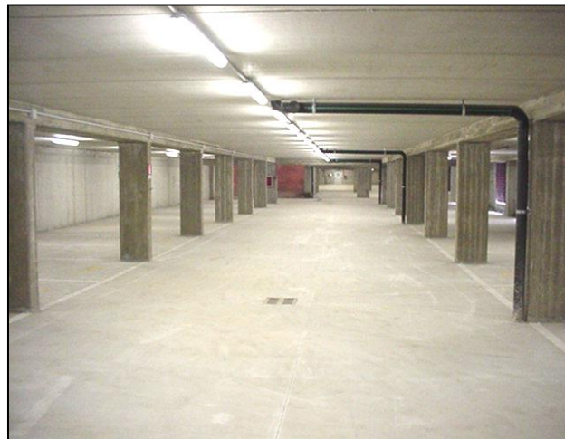
Autorimessa interrata con l'impiego di lastre tipo "predalles"
